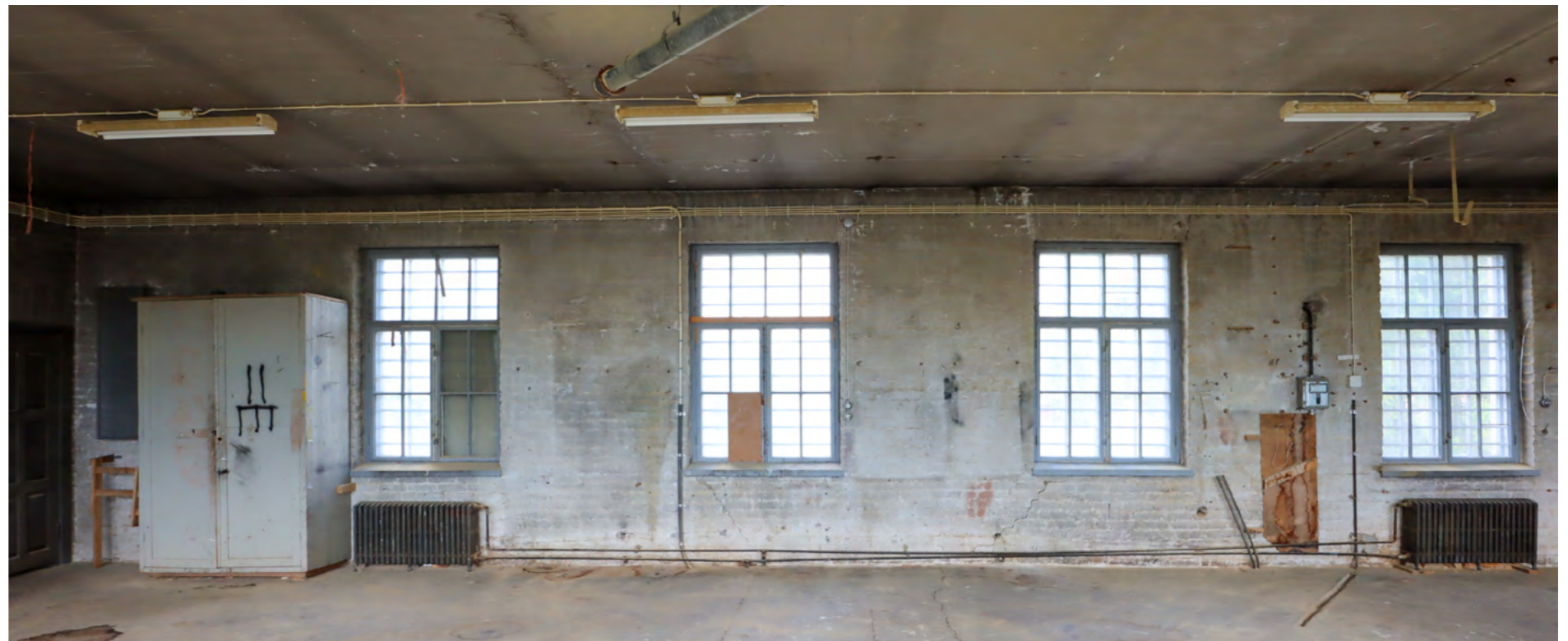
Kuva. 2. kerroksen puutyöverstas on säilynyt yhtenäisenä ja avoimena tilana. Myös alkuperäiset ikkunat kaltereineen ovat säilyneet.
