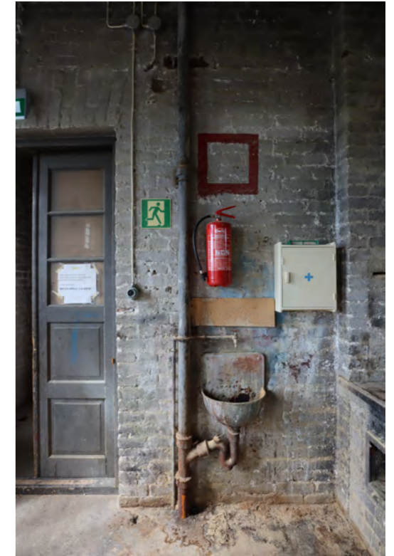
Kuva. Pinnat kaipaavat huoltoa ja kunnostusta. 2. kerroksen lattialle on valunut vettä ja vanhat vesikalusteet ovat huonossa kunnossa.
