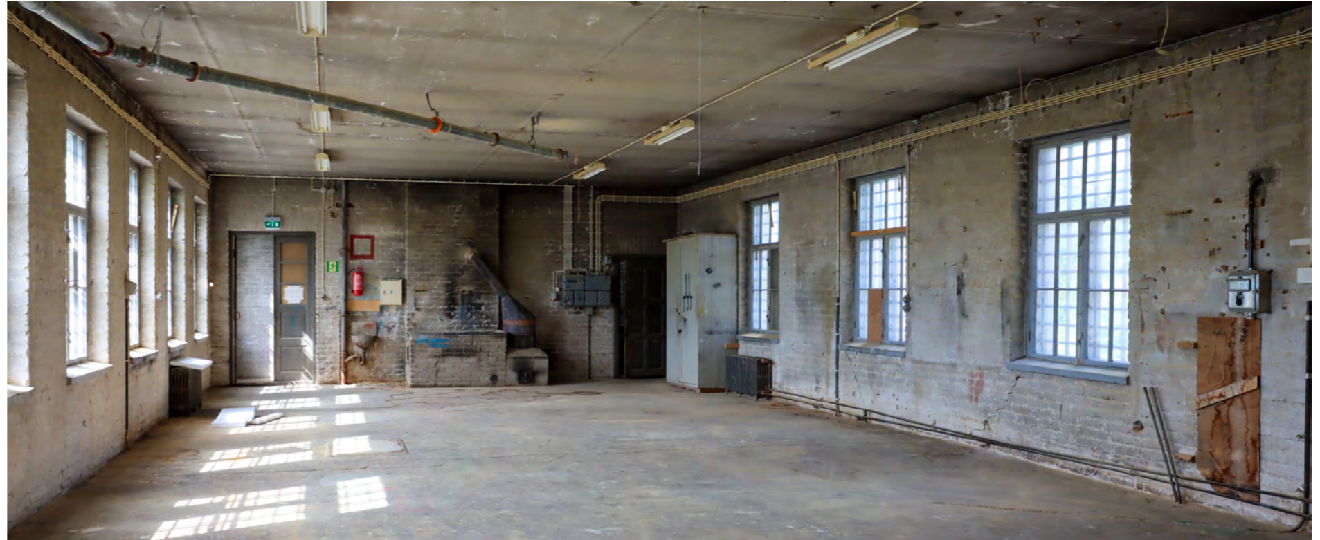
Kuva. Työpajarakennuksen 2. kerros on säilynyt yhtenäisenä avoimena tilana. Tulisija näkyy taustaseinällä.
