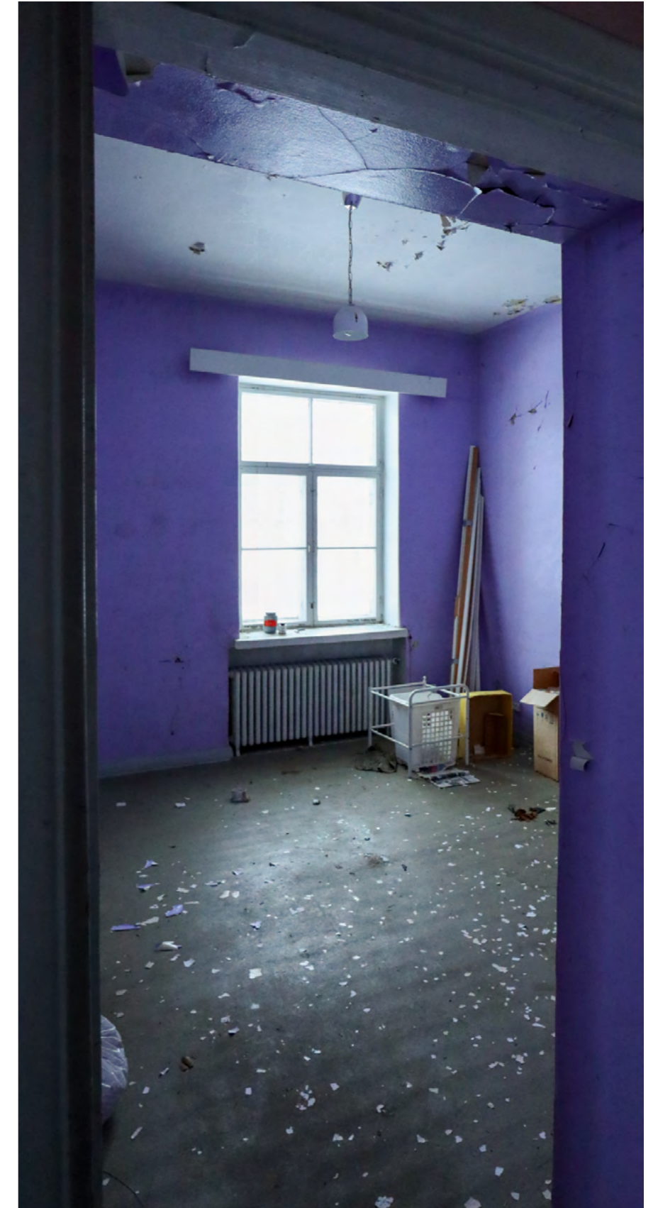
Kuvat. Vasemmalla ylhäällä: 1. kerroksessa on monia vanhoja peliovia. Vasemmalla alhaalla ja oikealla: Huoneita on muokattu purkamalla ja rakentamalla väliseiniä. Seiniä on maalattu kirkkailla väreillä. Alkuperäiset suuret puuikkunat ovat säilyneet.
