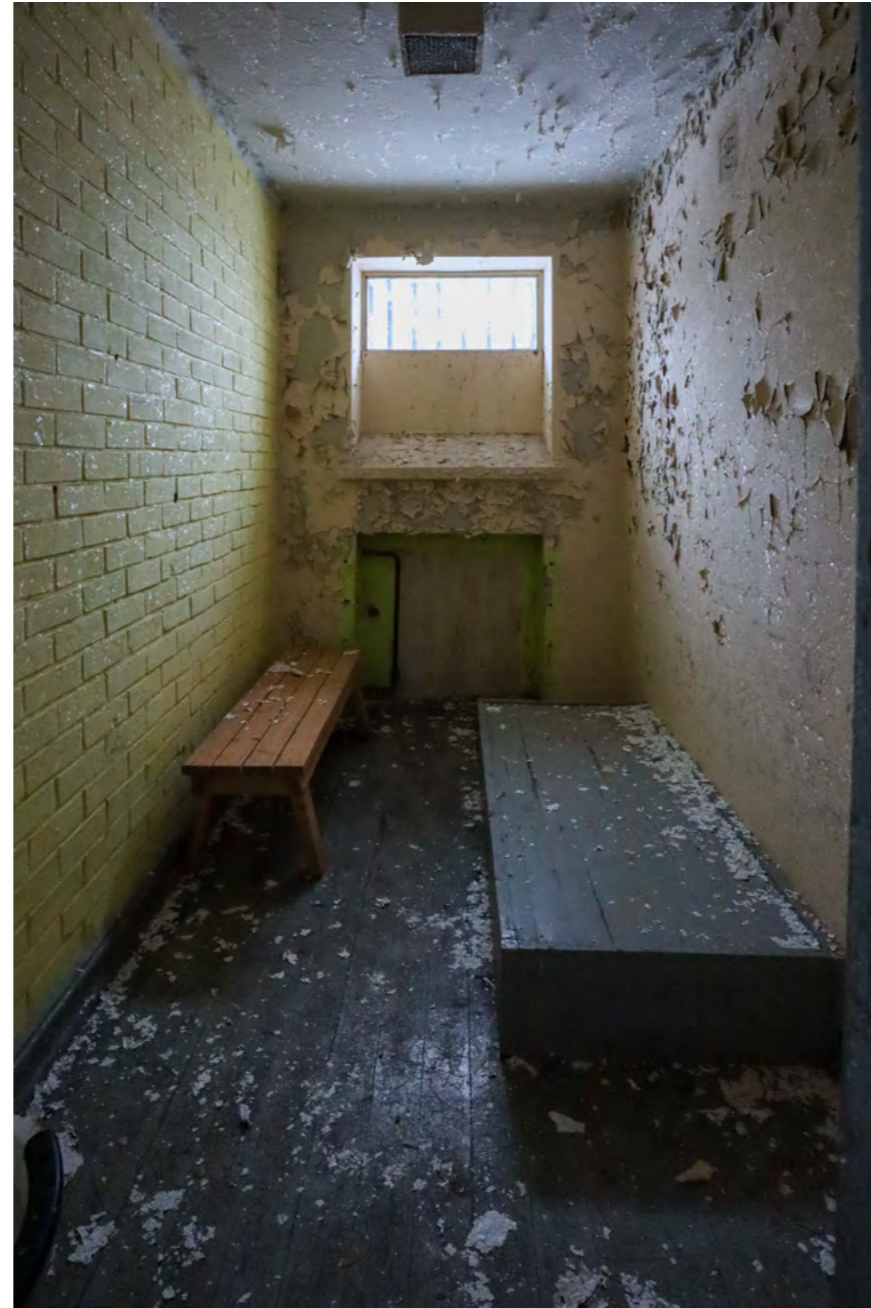
Kuvat. Eristyssellit sijaitsevat 2. kerroksessa sivusiipien päädyissä. Ovissa on järeät salvat ja lukot. Huoneissa on ikkunat korkealla, joista ei nähnyt ulos sekä kiinteät makuulaverit. WC:n vesisäiliö on sijoitettu sellin ulkopuolelle käytävään. .
