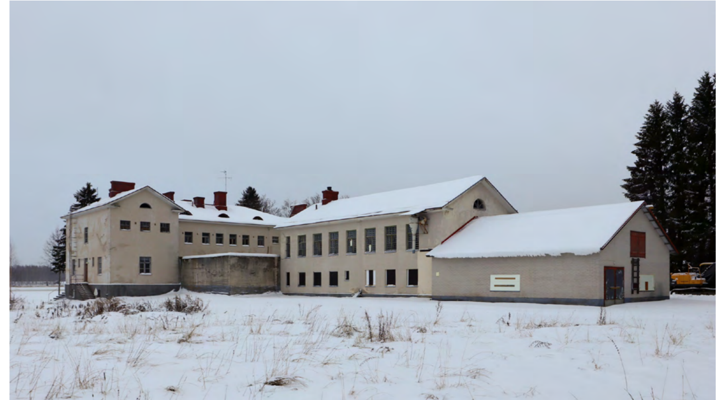
Leppäniemi sekä työpajarakennuksen vanha osa muodostavat kokonaisuuden, vaikka rakennukset eivät ole toiminnallisesti yhteydessä toisiinsa. Työpajarakennuksen uudempi osa on vähempiarvoinen.
