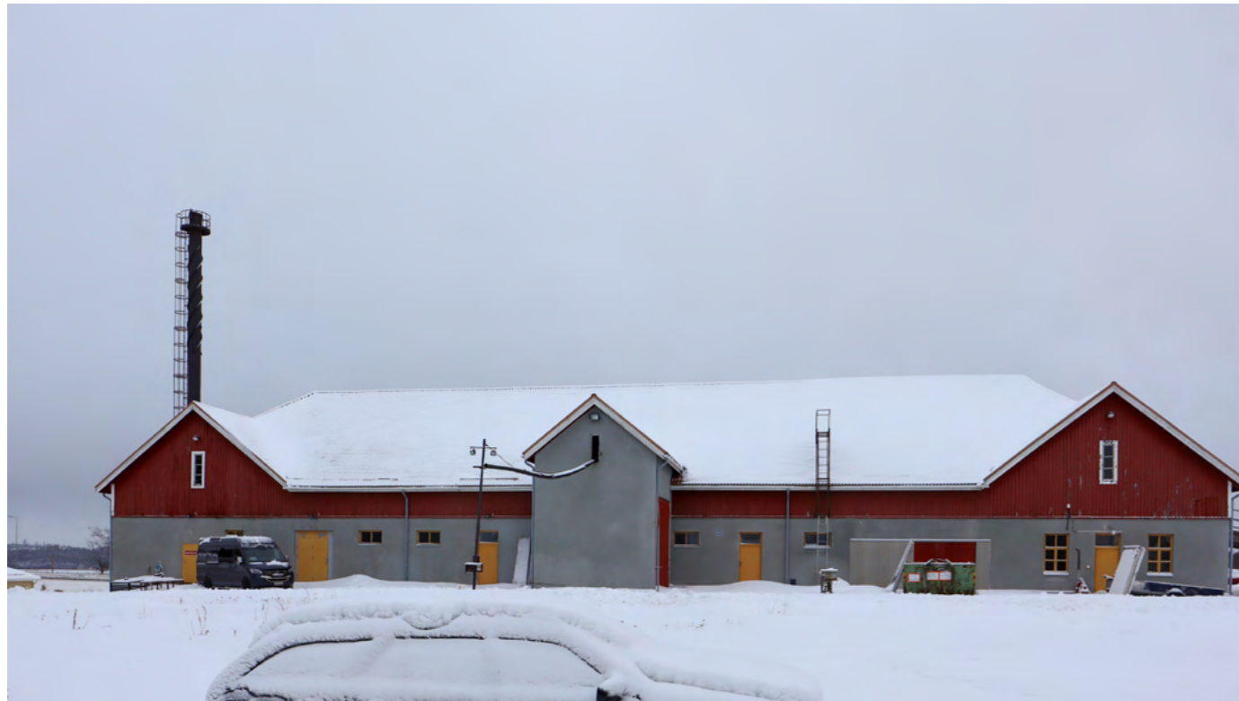
Kuvat. Karjarakennuksen julkisivuja.
