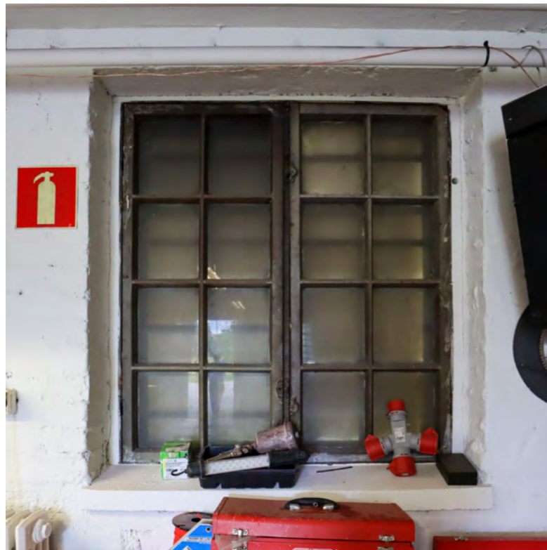
Kuva. Alkuperäiset ikkunat ovat säilyneet, vaikka ikkuna-aukot on ulkopuolelta peitetty. Sisäovet ovat kolmi- tai kuusipeilisiä valkoiseksi maalattuja puuovia.
