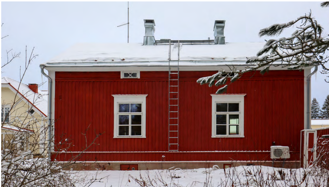
Kuva. Kukkolan julkisivuja.
