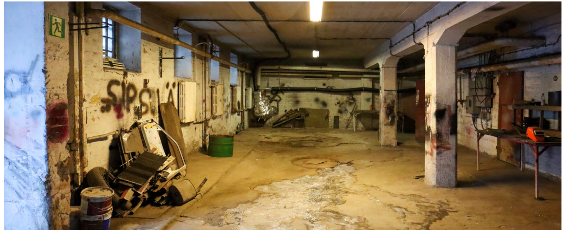
Kuvat. Entisen sementtivalimon tiloja kellarikerroksessa. Kellariin on valunut vettä, joka on jäänyt lattialle.
