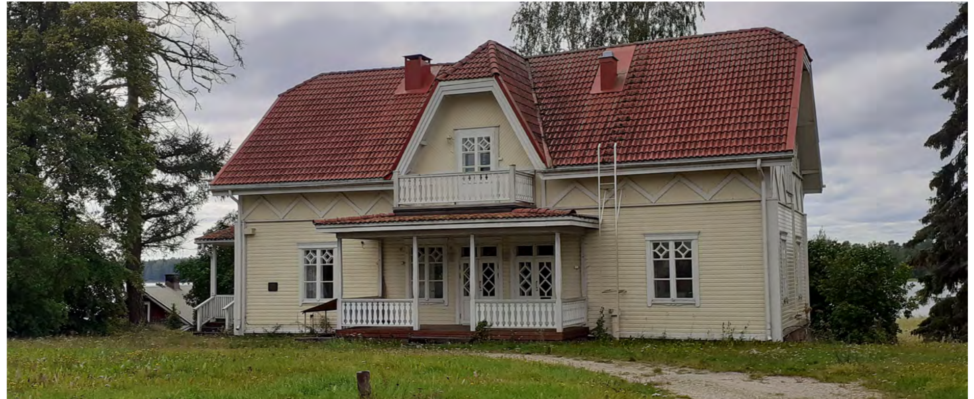
Kuva. Johtola I. Laukaan kunta.
