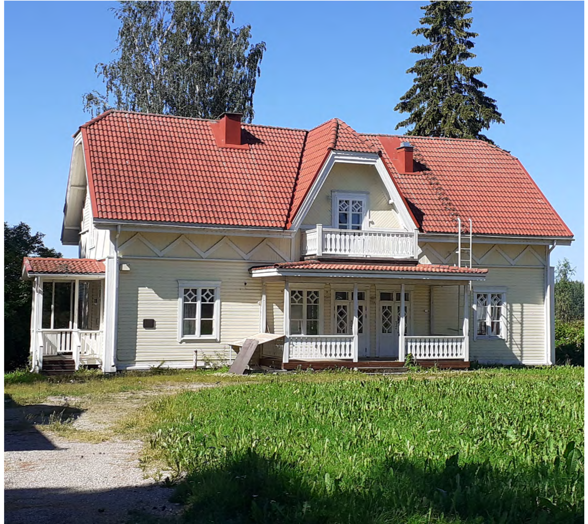
Kuva. Johtola I. Laukaan kunta.
