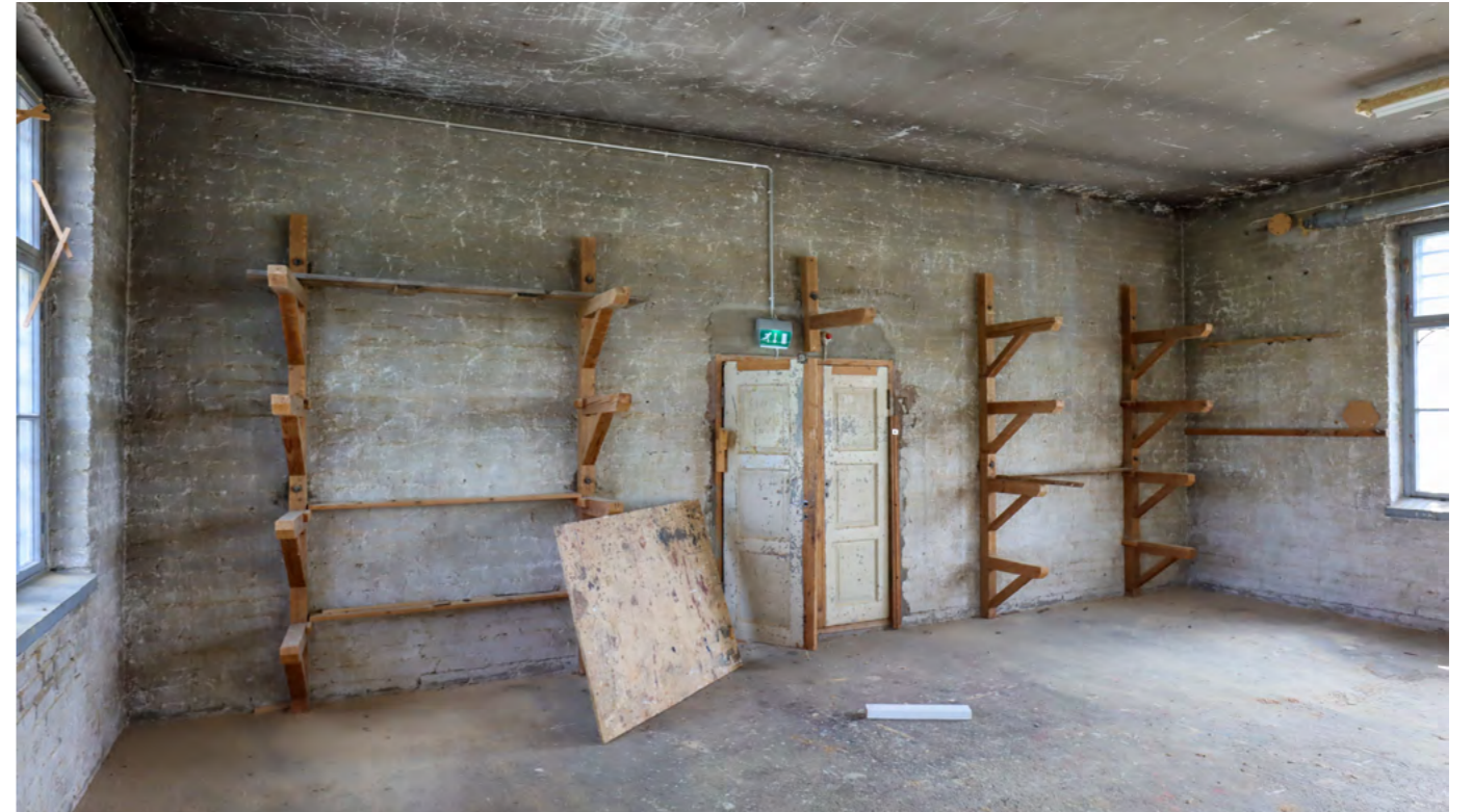
Kuva. 2. kerroksen länsipäädyssä on pariovi, joka johtaa laajennusosan ullakolle entiseen puutyövarastoon.
