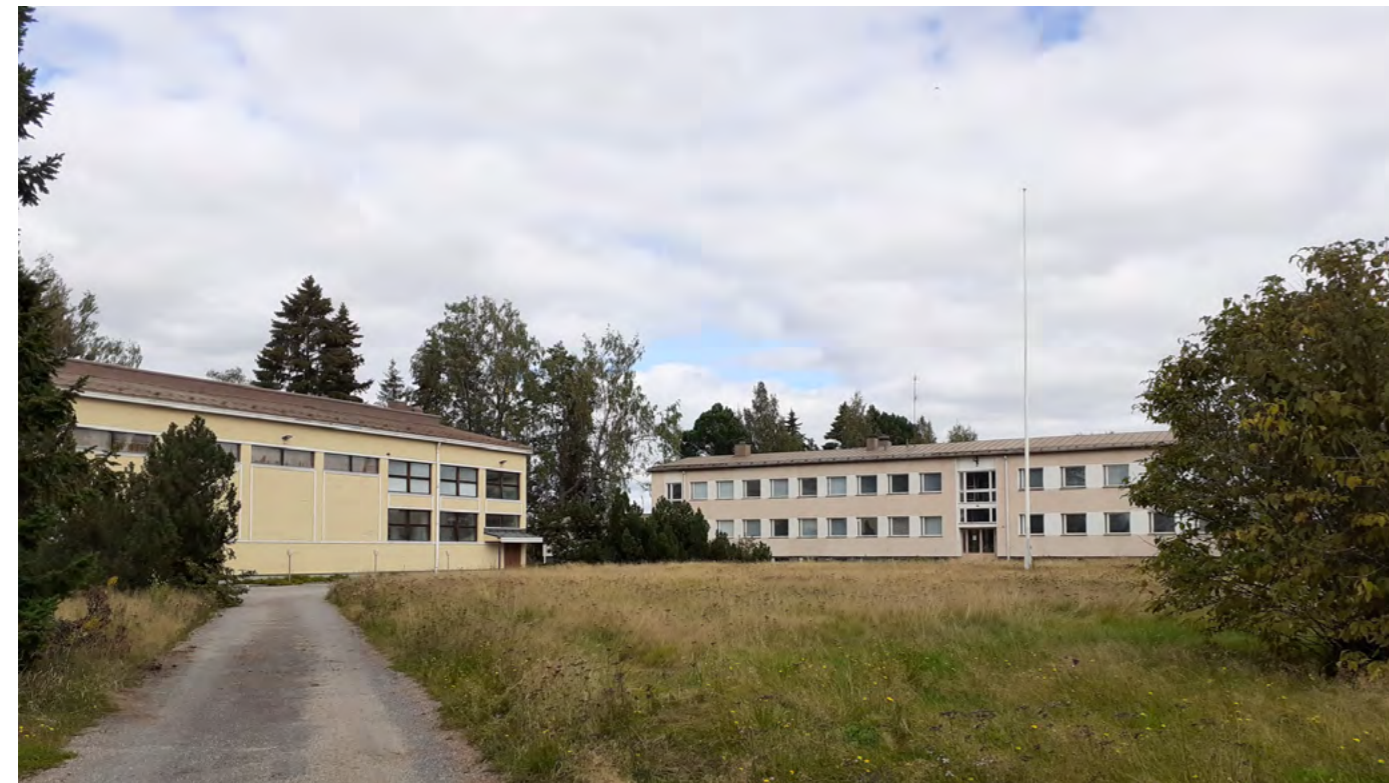
Kuva. Kuntola ja kotila rajaavat niittymäistä avointa aluetta kahdelta sivulta. Laukaan kunta.
