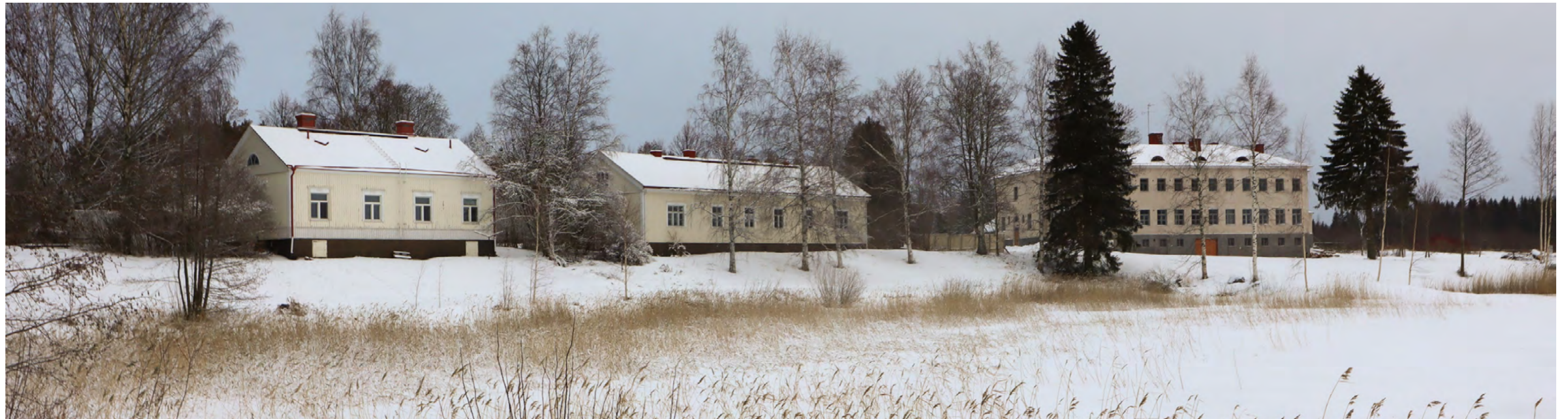
Johtola I:n, Pirttilän ja Kukkolan pihapiiri, Rantalan ja Linnankorvan muodostama pari sekä Leppäniemen ja työpajarakennuksen kokonaisuus muodostavat arvokkaiden rakennusten sarjan rantaan. Yhdessä rantapuuston kanssa ne muodostavat rannan siluetin Leppävedelle päin.
