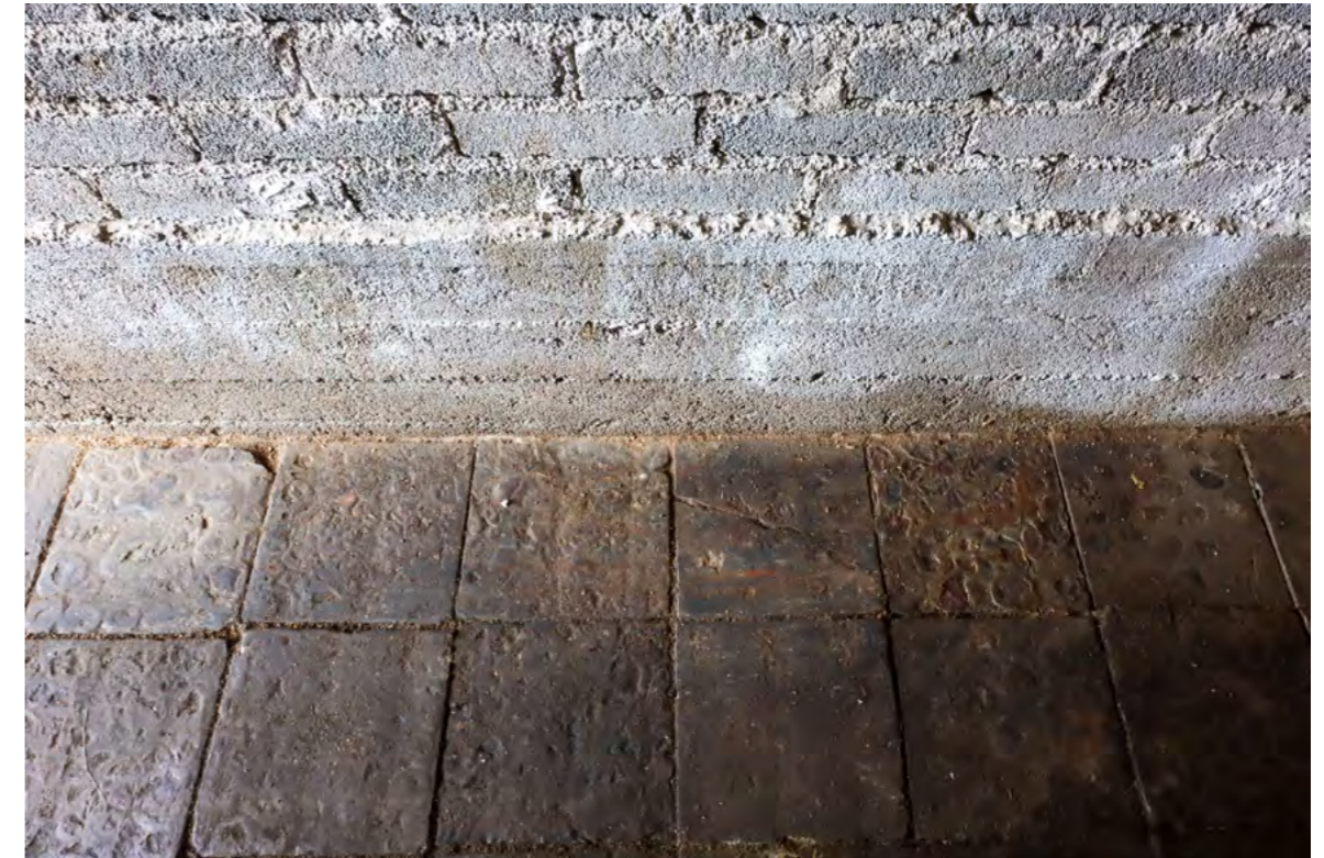
Kuva. Entinen öljykellari on tiloista pienin. Sen lattiassa on käytetty todennäköisesti Leppäniemessä valmistettua betonilaattaa.
