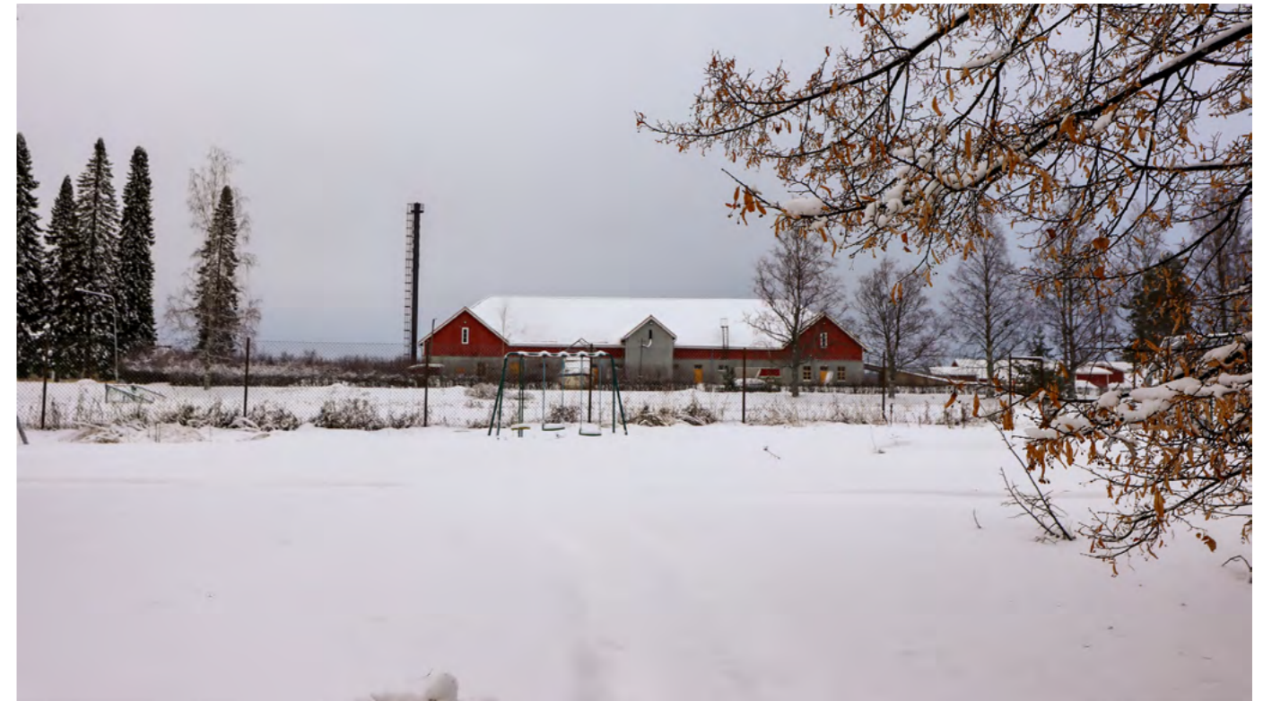
Kuvat. Avoimen urheilukenttäalueen reunalla sijaitseva karjarakennus erottuu kauas ympäristössään.
