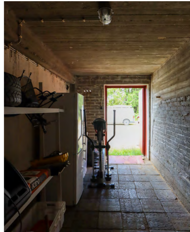
Kuva. Entinen öljykellari on tiloista pienin. Sen lattiassa on käytetty todennäköisesti Leppäniemessä valmistettua betonilaattaa.
