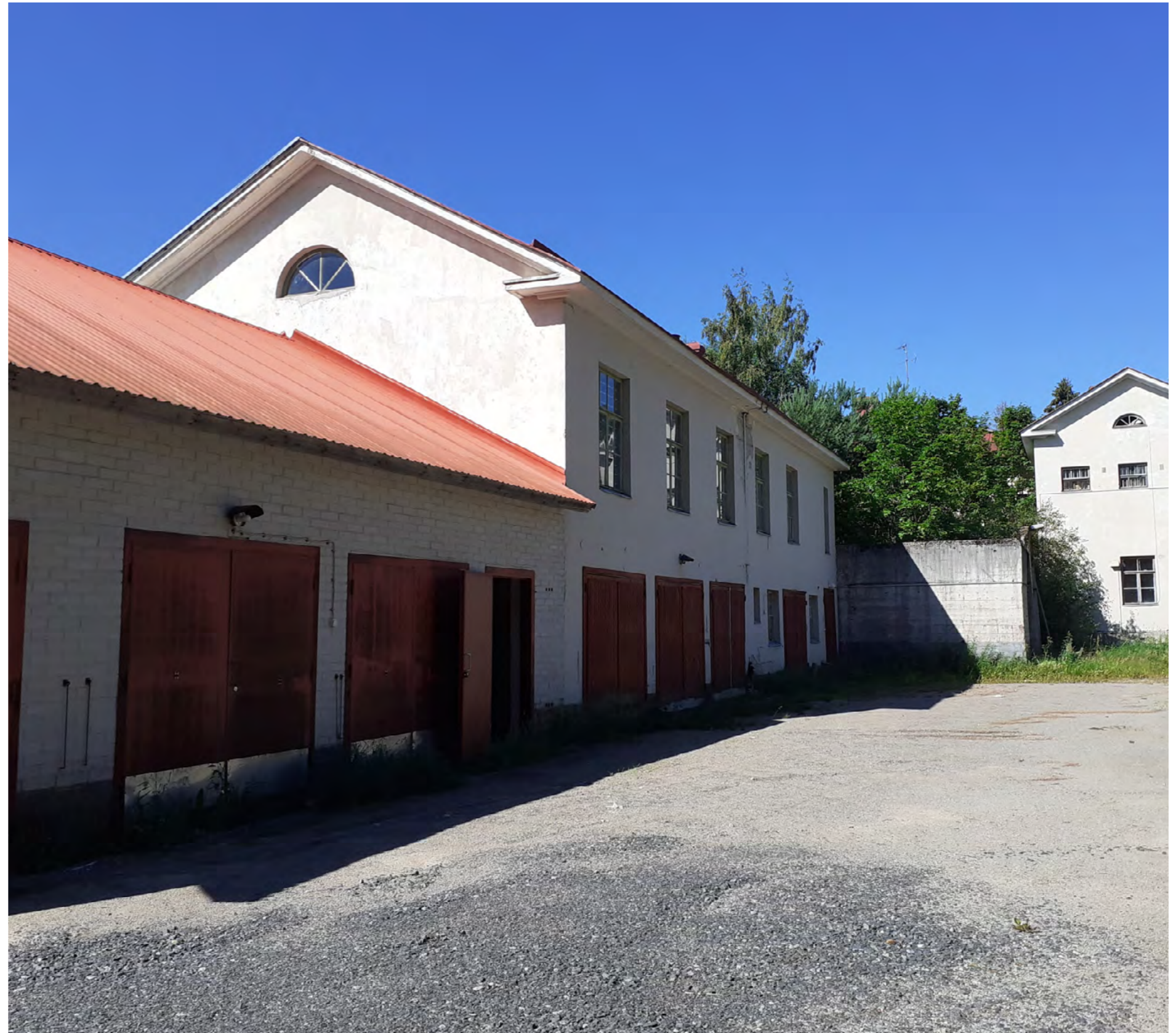
Kuva. Työpaja, etualla uudempi osa 1950- tai 1960-luvulta, jota seuraa työpajarakennuksen vanhempi osa. Taustalla erottuu Leppäniemen ulkoilupihan muuri sekä rakennuksen pääty. Rakennusten arkkitehtuurissa on samoja piirteitä, kuten hillityt ja sileät julkisivut, lunetti-ikkunat sekä päädyissä avoimet korniisit. Laukaan kunta.
