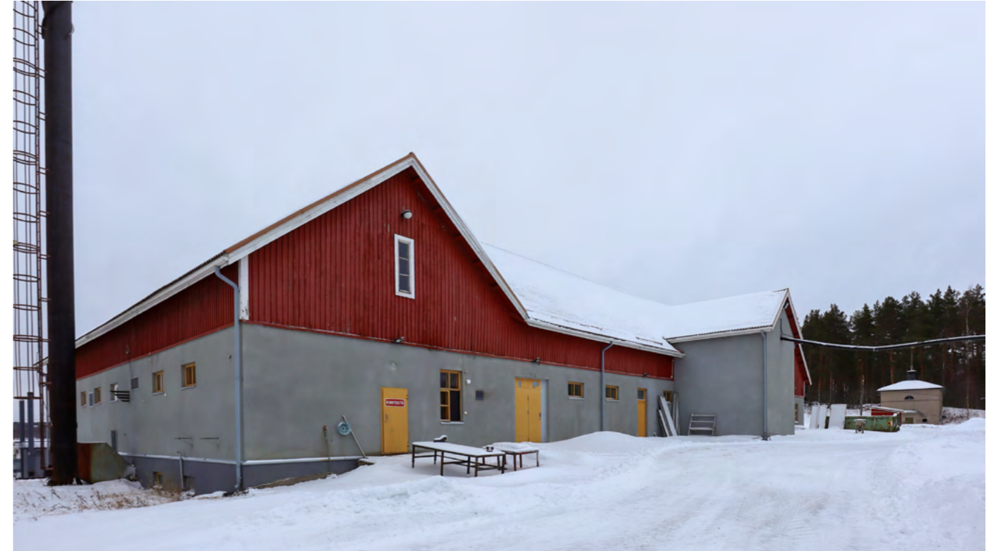
Kuvat. Karjarakennuksen julkisivuja.
