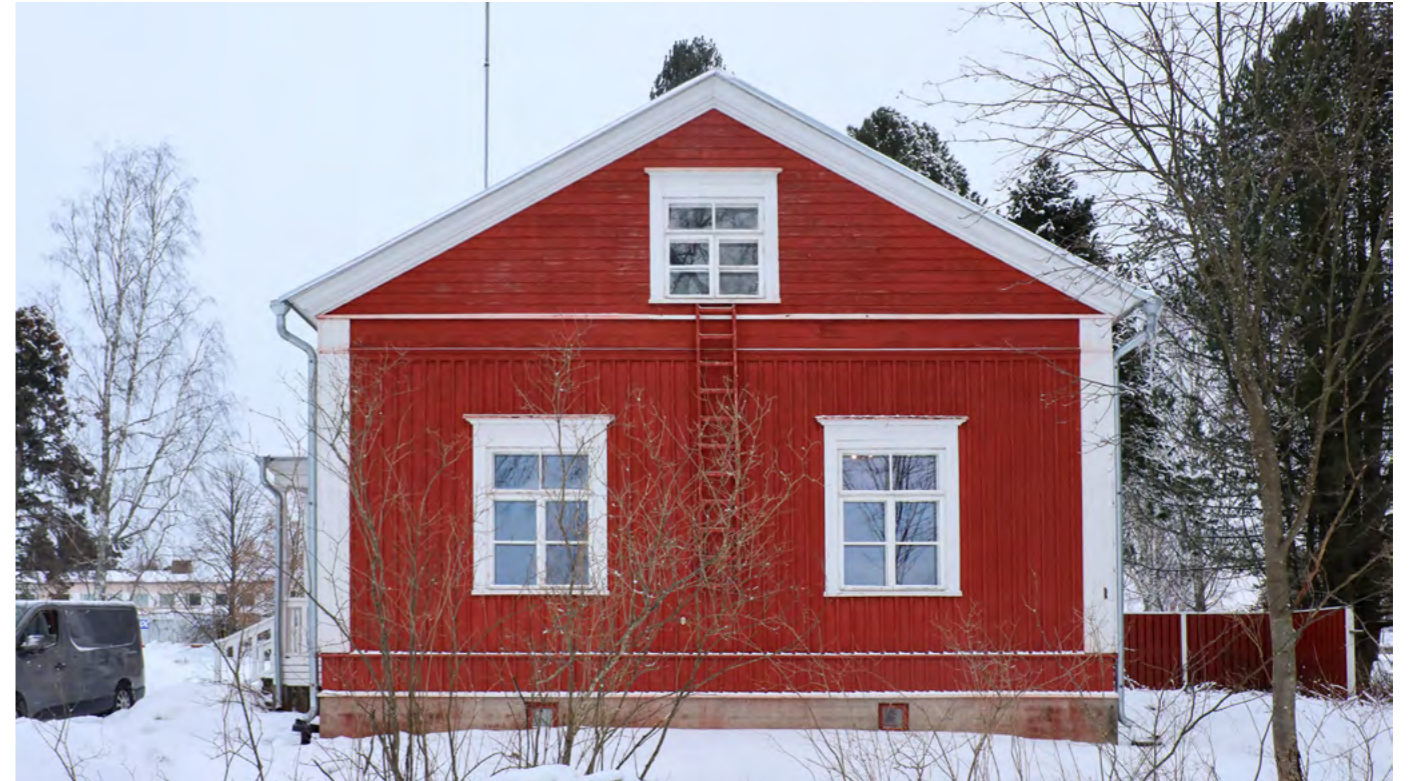
Kuva. Kukkolan julkisivuja.
