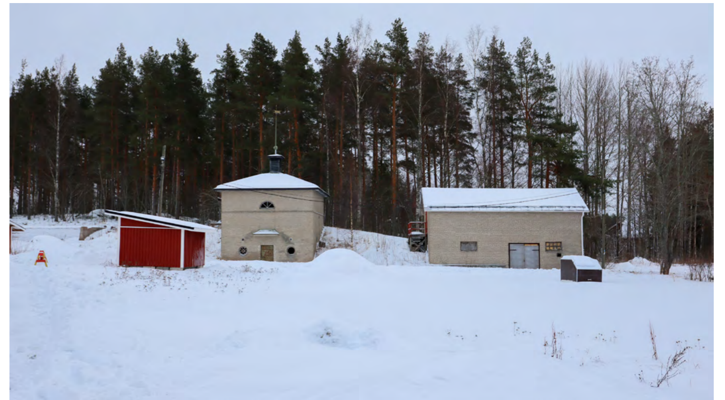
Myllyrakennuksen ja viljankuivaamon säilyttämistä alueen historiasta muistuttavana kokonaisuutena voidaan tutkia. Juureskellari rajautuu kuvan ulkopuolelle oikealla.
