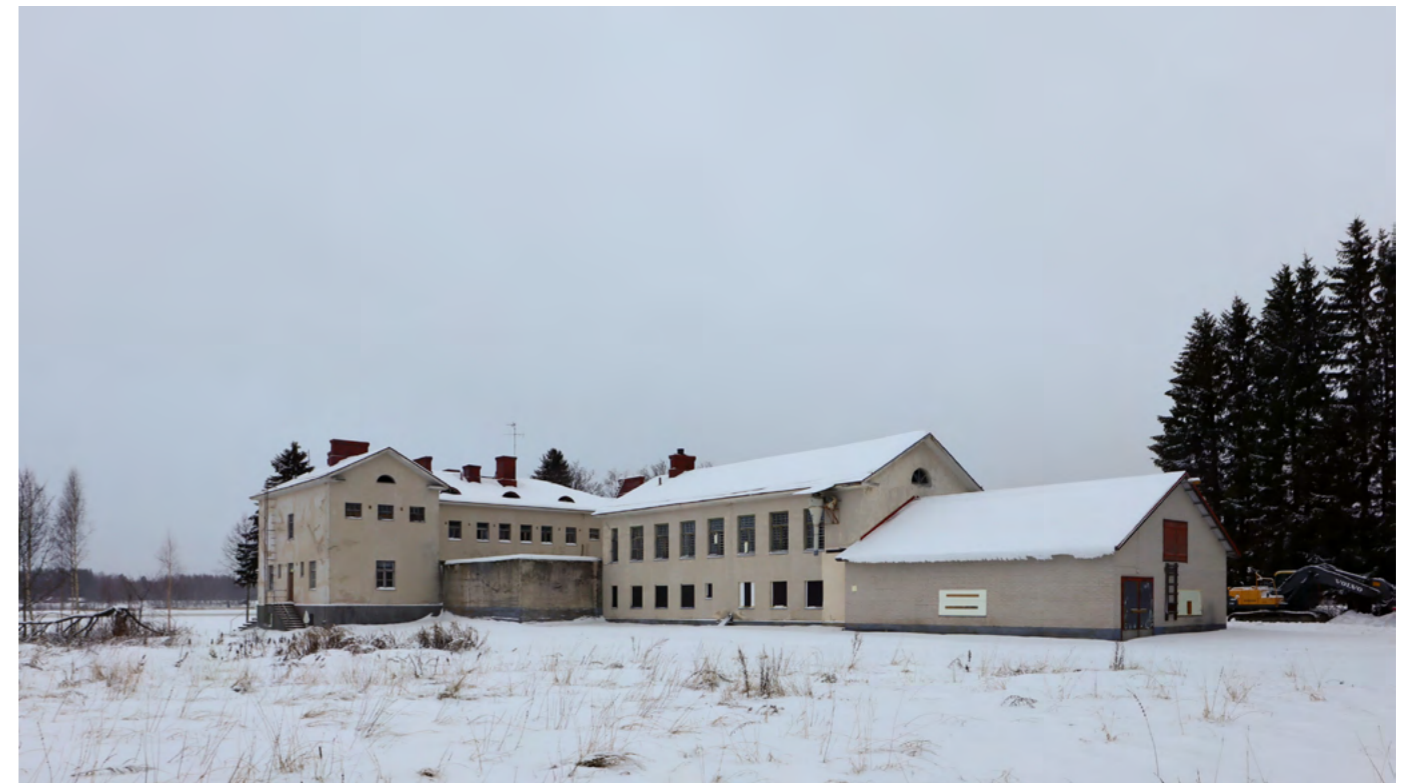
Kuva. Leppäniemen ja työpajarakennuksen muodostama kokonaisuus.
