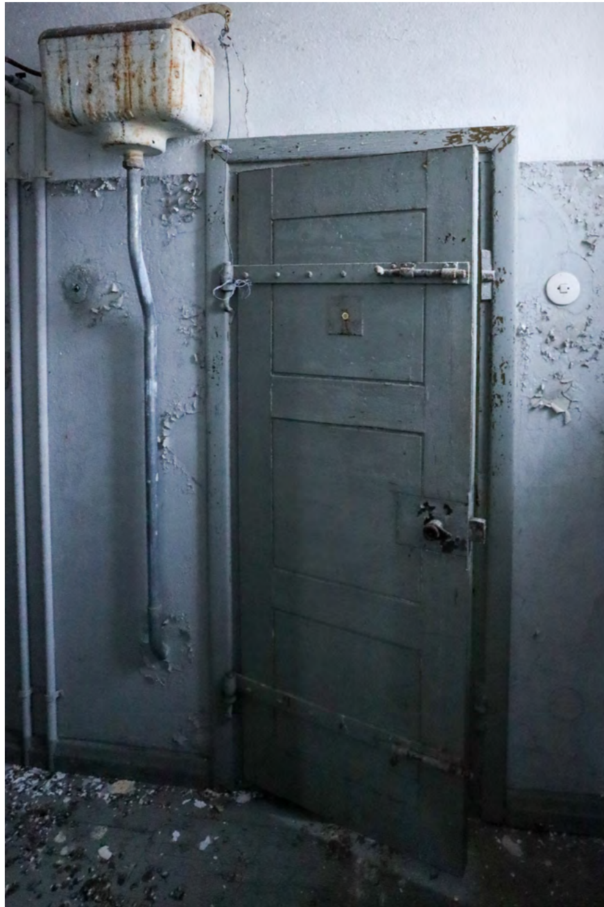
Kuvat. Eristyssellit sijaitsevat 2. kerroksessa sivusiipien päädyissä. Ovissa on järeät salvat ja lukot. Huoneissa on ikkunat korkealla, joista ei nähnyt ulos sekä kiinteät makuulaverit. WC:n vesisäiliö on sijoitettu sellin ulkopuolelle käytävään. .
