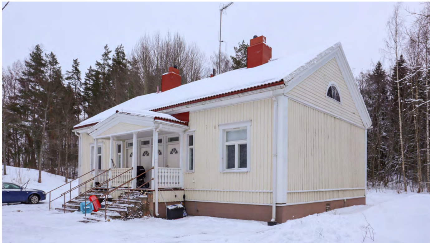
Kuva. Rajalan julkisivuja.
