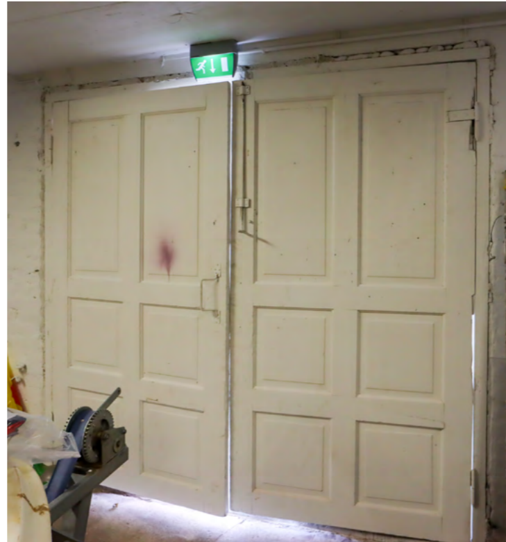
Kuva. Ulko-ovet on uusittu, mutta yhdessä ulko-oviaukossa ovat sisäpuolella säilyneet muiden sisäovien tyyliä vastaavat kuusipeiliset vanhat pariovet.
