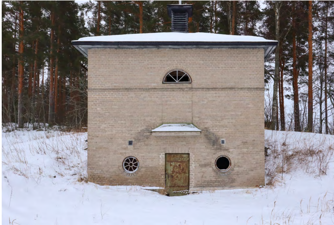
Kuva. Myllyrakennuksen julkisivu.
