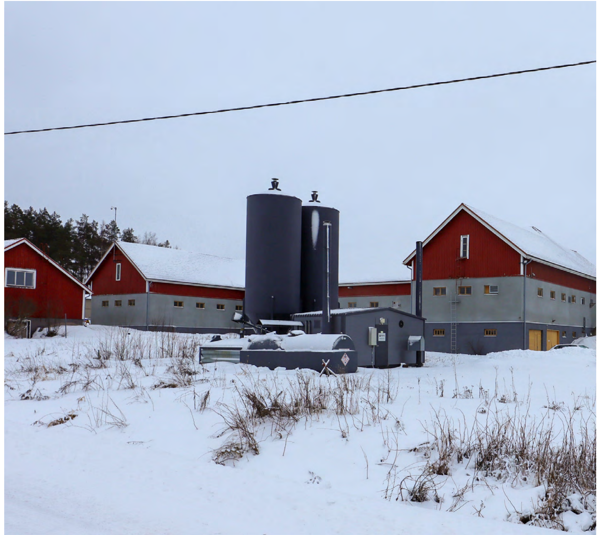
Kuva. Lämpökeskus navetan edessä.
