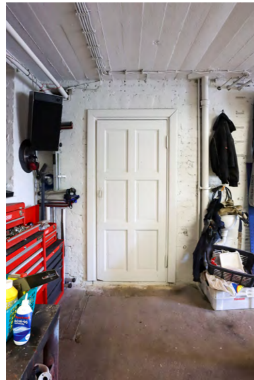
Kuva. Alkuperäiset ikkunat ovat säilyneet, vaikka ikkuna-aukot on ulkopuolelta peitetty. Sisäovet ovat kolmi- tai kuusipeilisiä valkoiseksi maalattuja puuovia.
