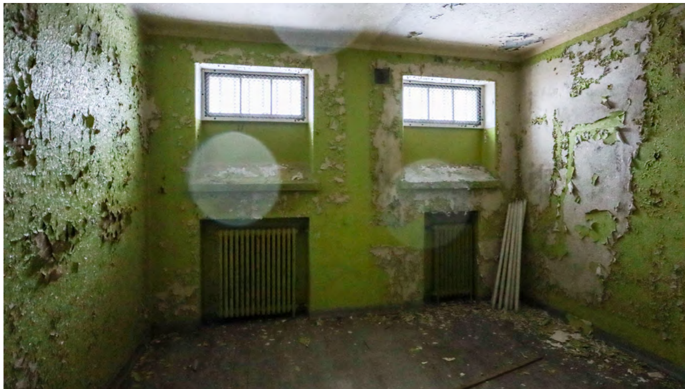
Kuvat. Leppäniemi on ollut pitkään vailla käyttöä ja sisätilat ovat huonossa kunnossa. Ylhäällä vasemmalla: Osa ikkunoista on rikki. Alhaalla vasemmalla: Kaksi eristysseiliä on yhdistetty yhdeksi huoneeksi. Maali on suurimmassa osassa rakennusta hilseillyt irti seinistä. Oikealla: Lattia on revitty auki yhdessä eristysseileistä.
