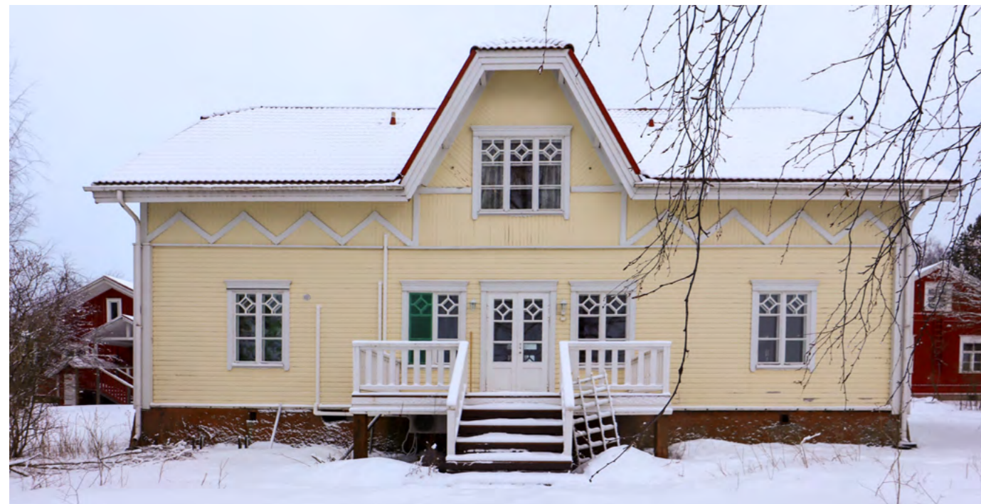
Kuvat. Johtolan julkisivuja.
