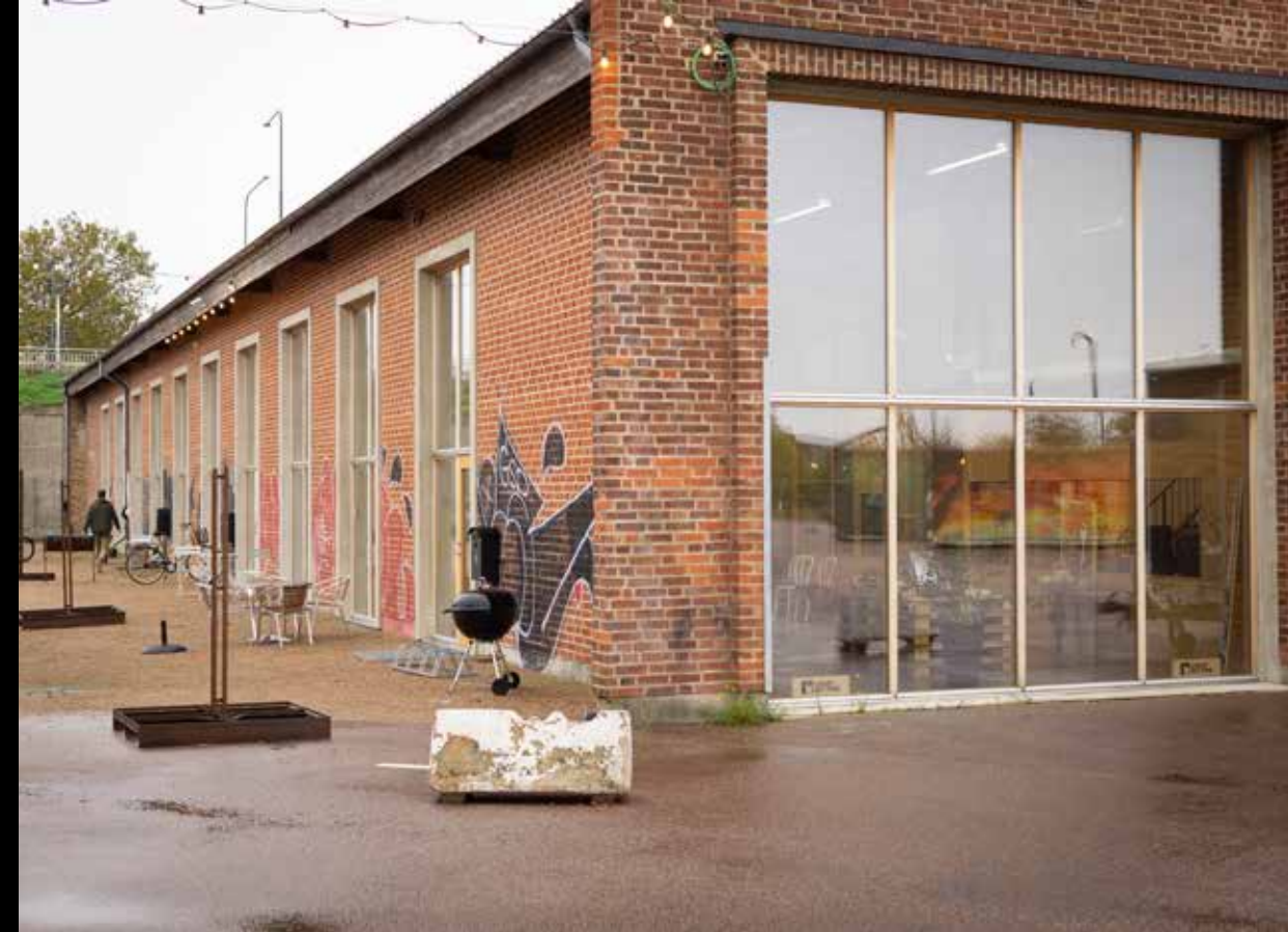
Sandböljan i Malmö – en gammal lagerbyggnad omvandlades till en hubb för studios, kontor och kreativa verksamheter. Foto: Tengbom
